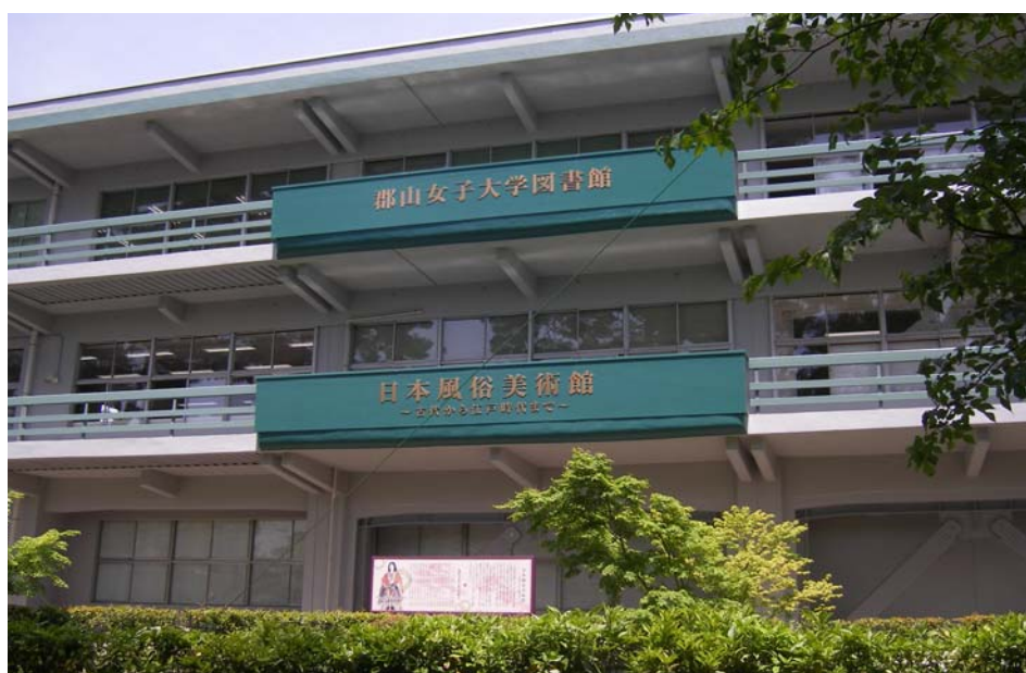
耐震補強工事の完了した郡山女子大学図書館 (2007年5月撮影)
